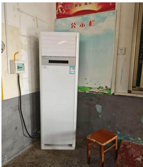
图 5：教室安装的新空调
